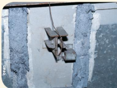
Sonde enrobée d'un mastic souple amianté
